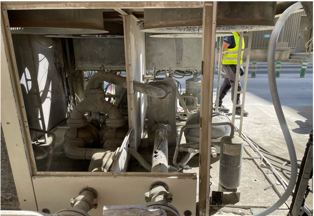
Vue de derrière
